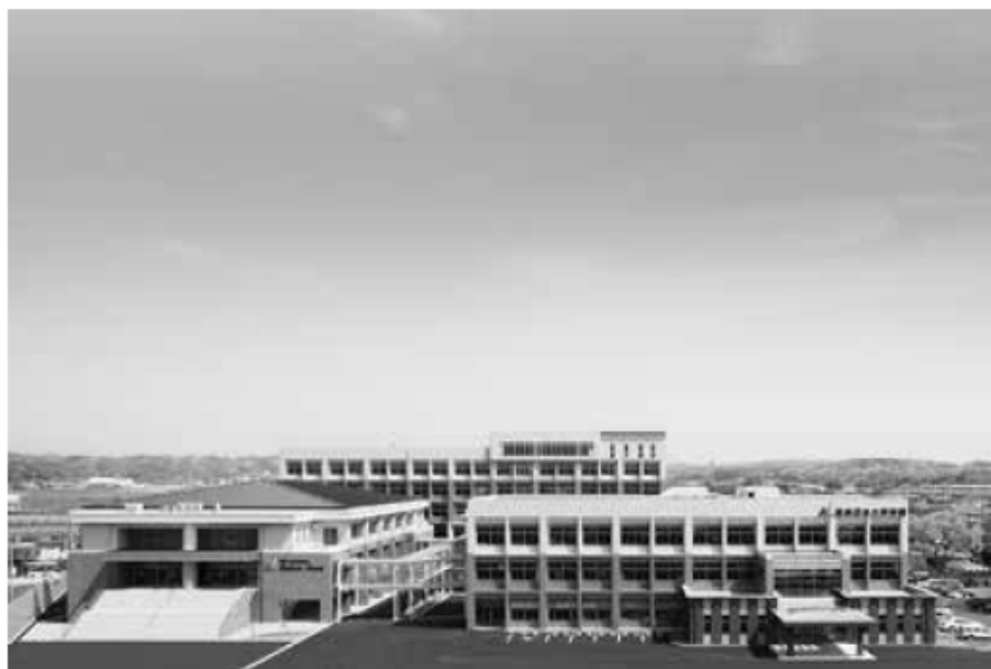
宮崎日本大学中学校・高等学校 校舎全景
